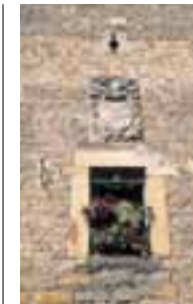
Torre de los Mendieta, en el pueblo del mismo nombre.
