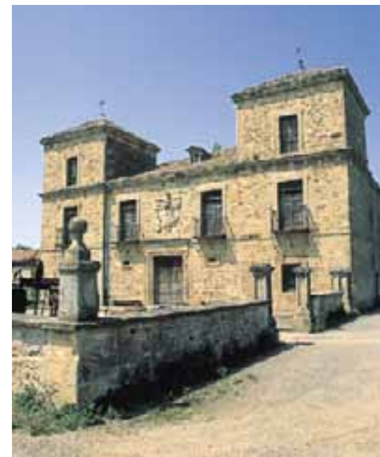
Palacio de los Otálora y Guevara (Zurbano).
