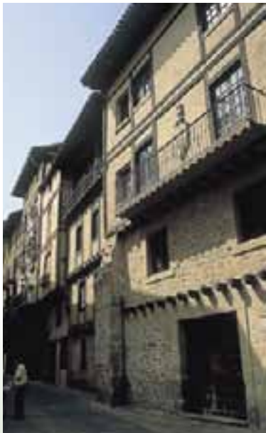
Torre de Los Iruña o de Doña Otxanda y casas de alforja en la calle Herrería. (Vitoria-Gasteiz)
