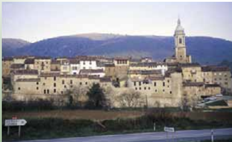
Villa de Antoñana con su muralla de poniente.
